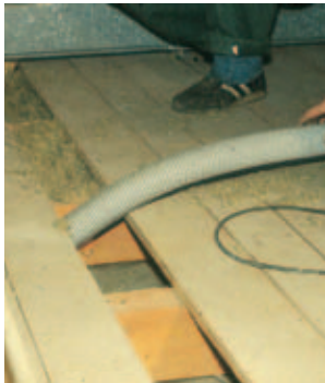
Dämmung einer Holzbalkendecke mit Rockwool Granulat
