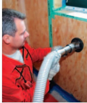
Ausblasen eines Außenwand-gefaches
