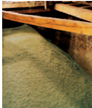
Abrutschsicher aufgebaute Dämmschicht
