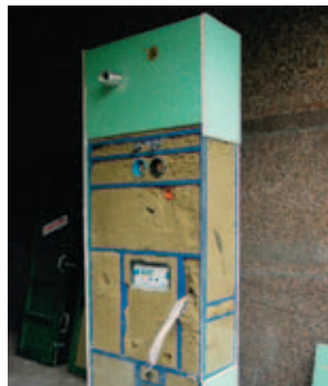
Schacht mit Firesafe-Granulat ausgeblasen
