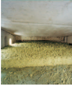
Belüftetes Flachdach mit Rockwool Granulat gedämmt
