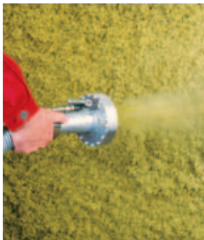
Benetzen der Steinwolle-Flocken mit Sprühkleber
