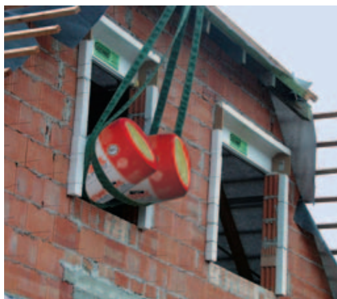
Einfacher Transport mit dem Baustellenkran
