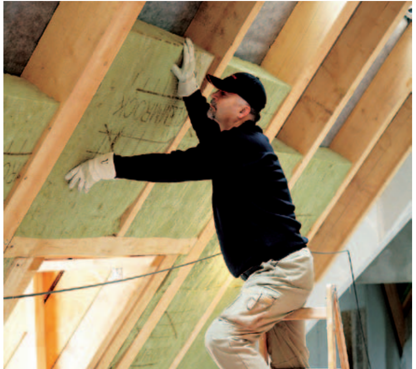
Klemmrock mit der Markierung nach innen einbauen
