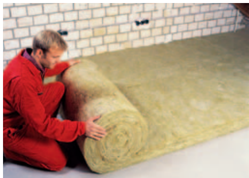
Ausrollen der Pentarock 035 bei einem nicht genutzten Raum
