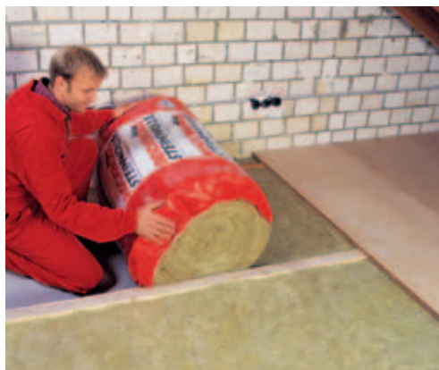
Verlegen der Pentarock 035 zwischen Lagerhölzern bei einem genutzten Raum
